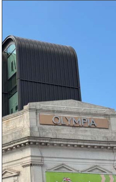
Kombination aus Alt und Neu. Der geschwungene Teil gehört zu einem Hotel.
